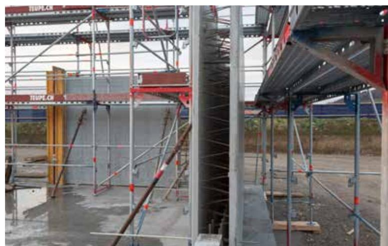
Betonwände mit vorgefertigten Elsässer-Elementen (8.1.2015, Urheber: U. Niederer)
