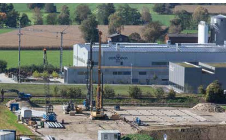
Fundamentierung mit Rammpfählen (19.10.2014, Urheber: U. Niederer)
