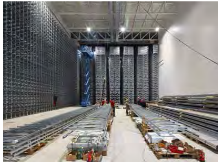
Die Gestelle des Hochregallagers im Bau (18. Sept. 2015)
