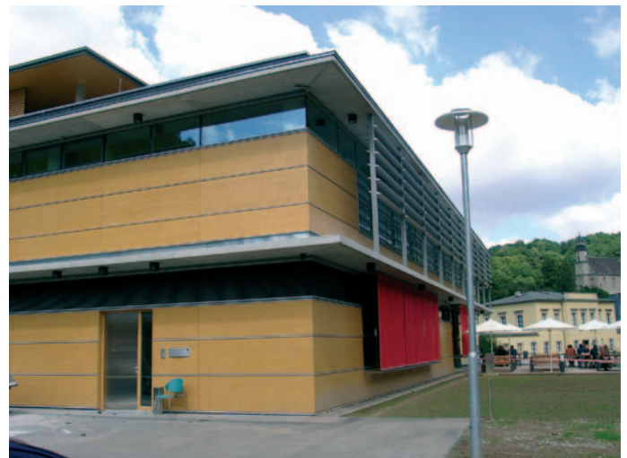
Oktober 2005: Der Neubau in zentraler Lage des Tharandter Campus beherbergt neben der Zweigbibliothek Forstwesen auch die Mensa.
